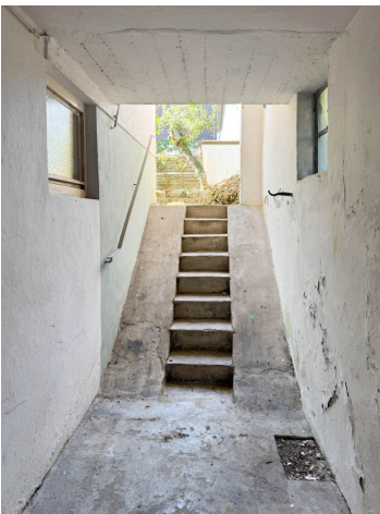
UG Treppenaufgang aussen
